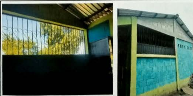
Foto 12: Modulo de Aula para pre primaria, donde se coloco lamina lisa en reja o balcon existente para proteccion de aula
