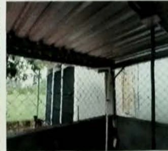
Foto 6: Vista exterior de modulo de lavanderia, instalacion de lamina troquelada cal 26.
