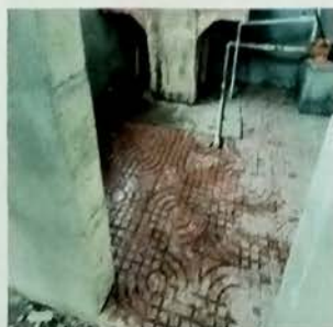
Foto 5: Vista Interna de modulo de lavanderia , colocacion de pios de grantia para patio, levantado de muro con block pomez e instalacin de malla metalica.
