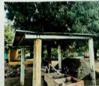
Foto 6: Vista exterior de modulo de lavanderia, instalacion de lamina troquelada cal 26.
