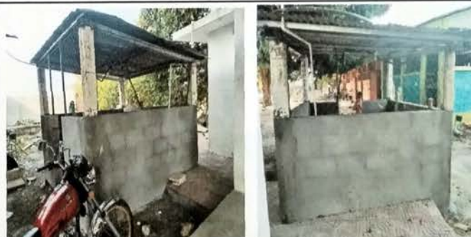
Foto 10: Vista exterior de area de lavanderia donde se realizo levantado de block al perimetro, se instalo lamina troquelada cal 26.
