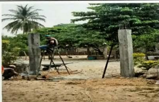
Foto 9: Vista de Fundicion de columnas para sosten de porton de ingreso al centro escolar.
