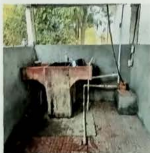
Foto 5: Vista Interna de modulo de lavanderia , colocacion de pios de grantia para patio, levantado de muro con block pomez e instalacin de malla metalica.
