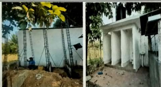
Foto 11: Vista de proceso de levantado de muros para modulo de servicios sanitarios.
