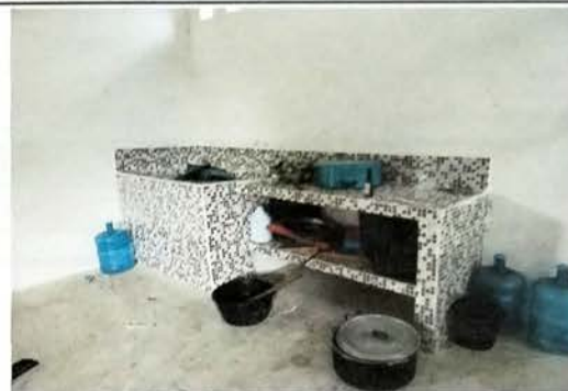
Foto 8: Vista de construccion de pila de concreto con revestimiento de azulejo. En modulo de cocina realizado por la primaria.
